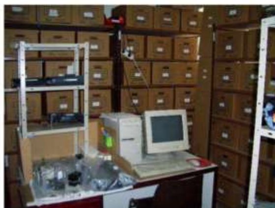
Panel de control almacenamiento de cartuchos
